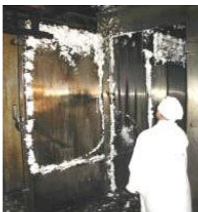
Нанесение пены с помощью пеногенератора
