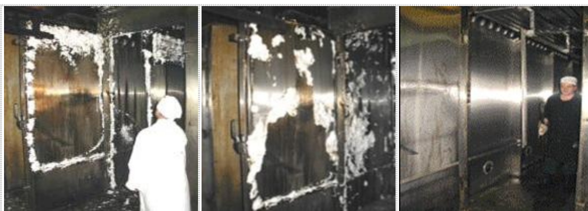
Нанесение пены с помощью пеногенератора
